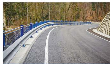
Svodidlo ZMS4-A3/H2 se svislou zábradelní výplní na opěrných zdech silnice III/1042 u obce Zahořany.
