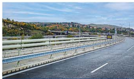
Barrandovský most se svodidlem ZMS4-A3/H2.
