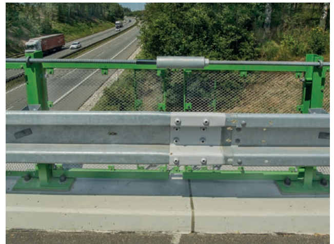
Svodidlo ZMS4-1/H2 na mostě 12936-1 přes D1 u Jiřic
