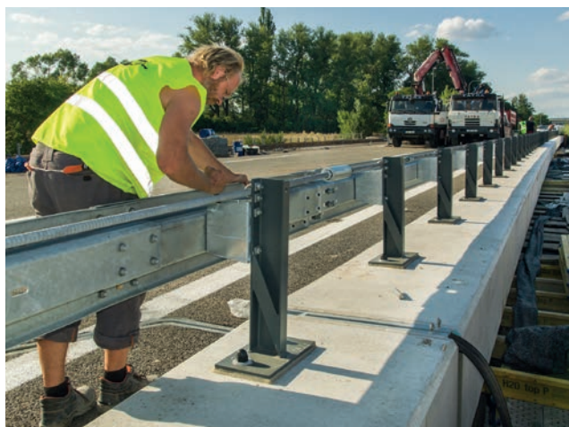
Instalace svodidla MS4-1/H2 na mostě D2-002
