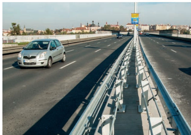
Středová mostní svodidla OMO MS4/H2 na mostě
