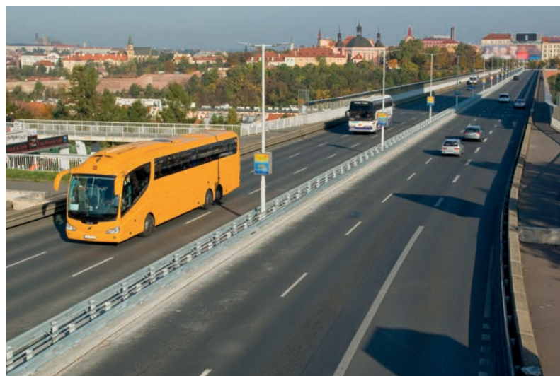
Nuselský most s nainstalovanými středovými svodidly MS4/H2
