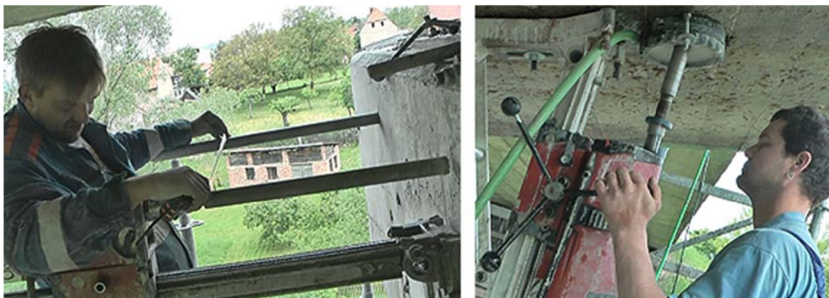
Obr. 5 Postup vrtacích prací, horizontální a vertikální vrty
