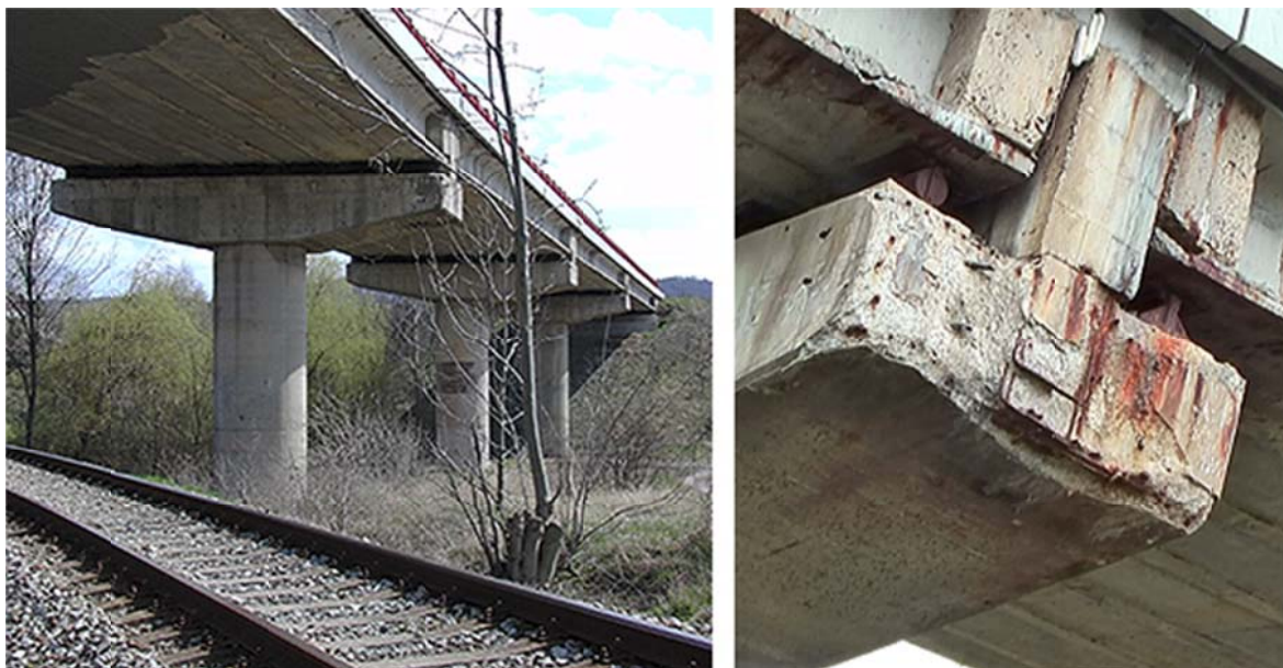
Obr. 1 Křížení mostu se železnicí a vzhled stativ mostu
