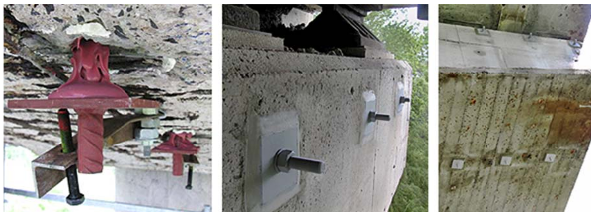
Obr. 6 Detail patky vlepené vertikální tyče a závěrečný vzhled zesíleného stativa
